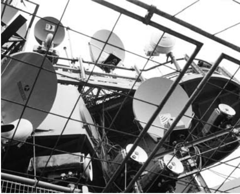
Antenne micro-onde au sommet de la Tour Eiffel à Paris. (Photo E.H.)
